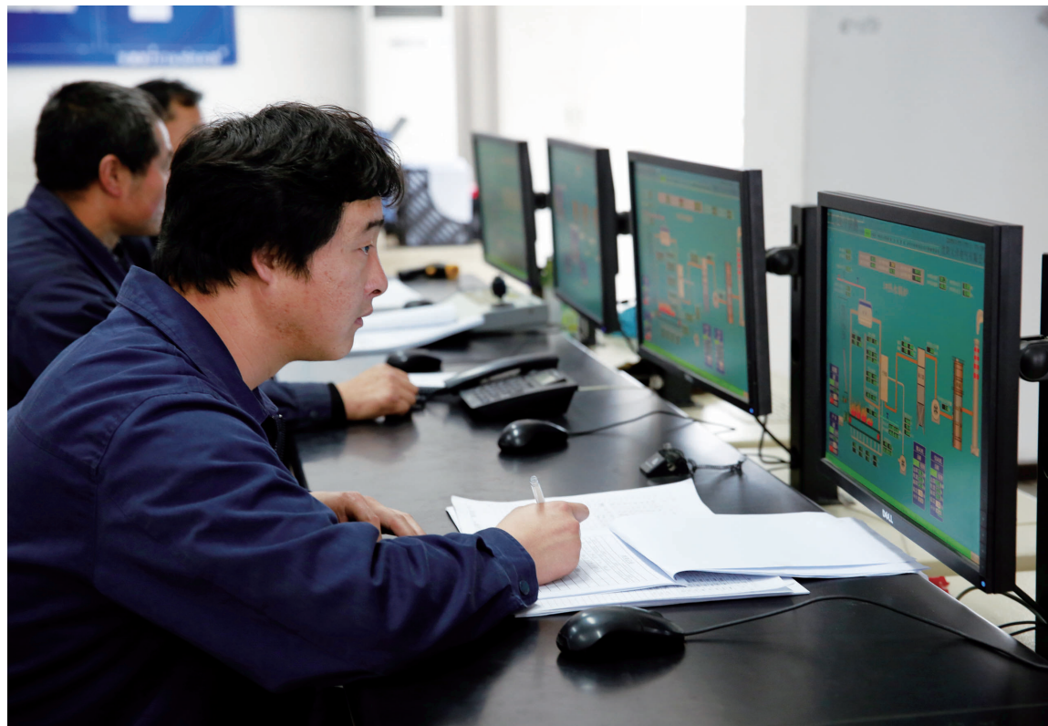
图为供暖公司工人在电脑前监控各项数据。 姚宝良/摄
